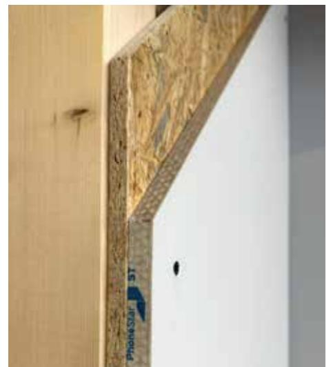
OneFrame-Wall Finish stabilisce nuovi standard nel campo dell'isolamento acustico.
